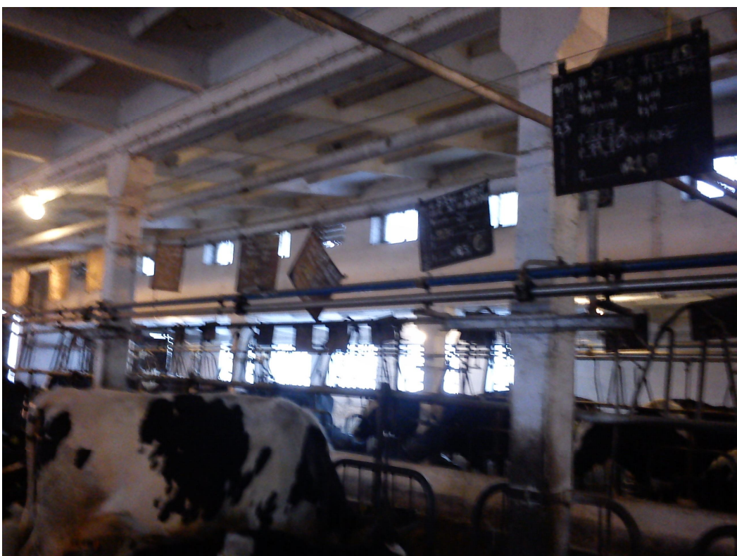
Fot. 1, 2 – wnętrze obory, widoczna konstrukcja żelbetowa oraz strop z płyt prefabrykowanych
