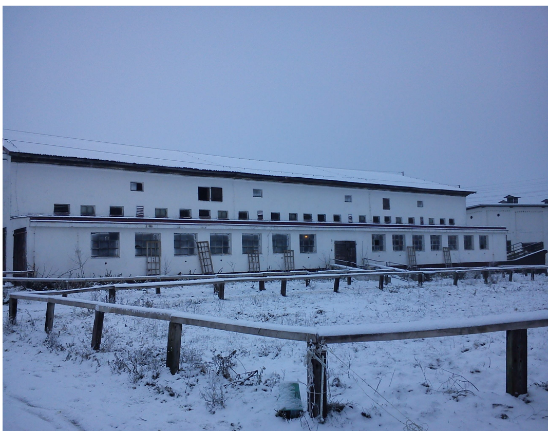
Fot. 4 – widok od strony północnej
