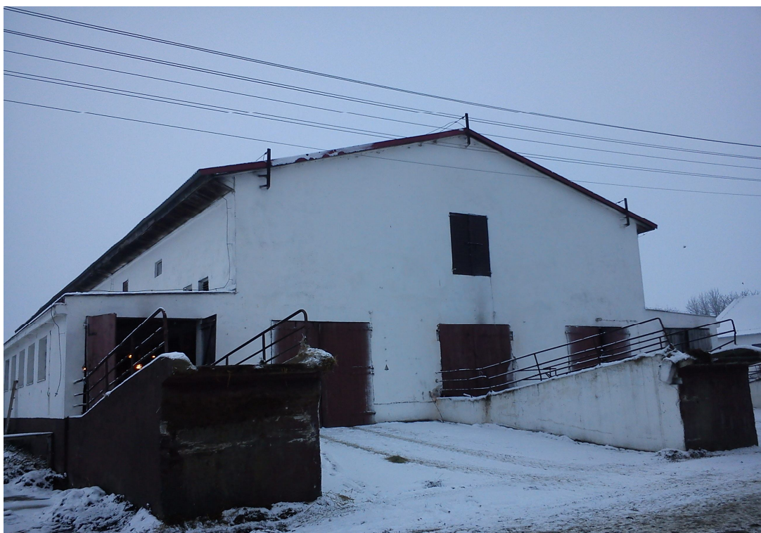
Fot. 3 – widok od strony wschodniej
