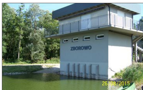
Fot. 2. Budynek pompowni Zborowo adoptowany na magazyn sprzętu pływającego Fot. 2. Building pumping Zborowo adapted to store water equipment
