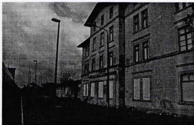
Fot. 1. Zdekapitalizowana infrastruktura dworcowa w Casekow.
