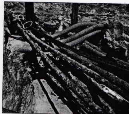
Rys. 2. Przykład zastosowania technologii Rauliner w bardzo trudnych warunkach (ulica Przemysłowa w Poznaniu) (foto: J. Wiernicki) Fig. 2. Example of use Rauliner's technology in very difficult circumstances (Przemysłowa street in Poznań) (foto: J. Wiernicki)
