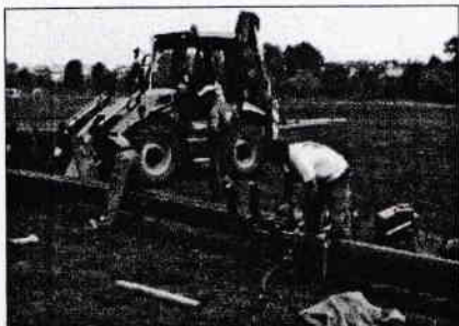
Rys. 3. Proces doczołowego zgrzewania rury (foto: J. Wiernicki) Fig. 3. Process of butt fusion pipe's welding (foto: J. Wiernicki)
