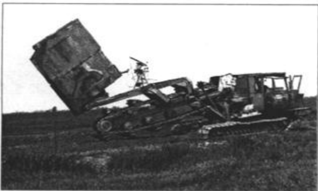
Fot. 3. Koparka drenarska ETC-202 (archiwum IM, KSiG UP w Poznaniu)
