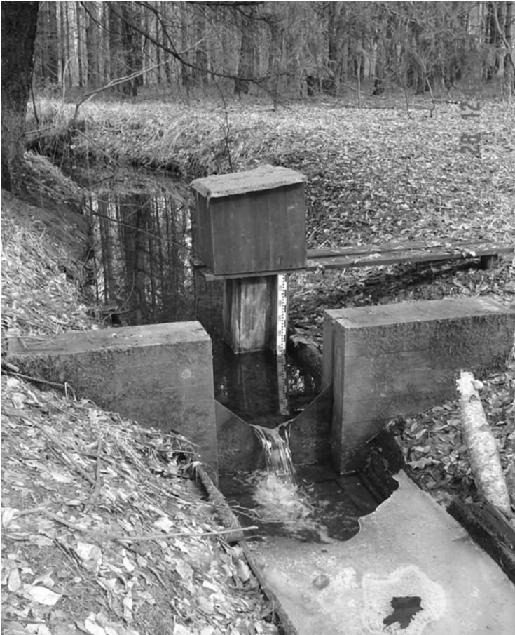
Rys. 1. Obiekt małej retencji wodnej
