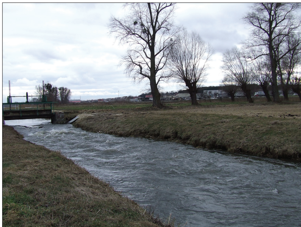
Fot. 1. Wysokie stany wody w Kani poniżej km 1 + 274
